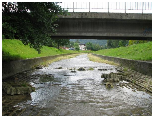
Fot. 12. Żylica – fragment rzeki z widocznym profilowaniem oraz umocnieniem dna (obserwacje HIR, WIOŚ 2018)
