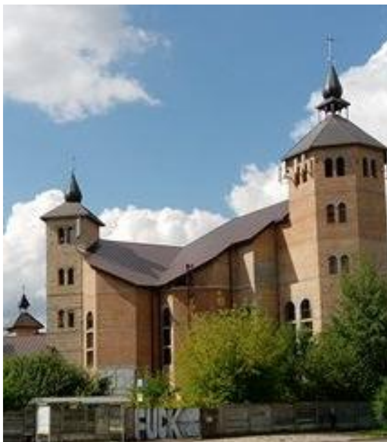
Fot. 1: Widok anten stacji bazowych: ID: BT43917, ID: OLS1028_D, ID: 34026 (44026N!), zlokalizowanych pod adresem: ul. Wilczyńskiego 7, 10-686 Olsztyn
