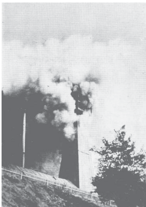
Rys. 6.8. Niekontrolowana erupcja dwutlenku węgla podczas wiercenia otworu nr 11 (Zuber II) w Krynicy Zdroju (17.07.1933 r., fot. inż. Frank; wg Świdzińskiego, 1953).
