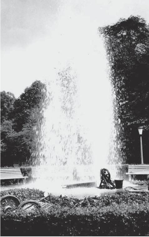
Rys. 7.4. Wyływ szczawy z odwiertu Pieniawa Chopina w Dusznikach Zdroju podczas prac rekonstrukcyjnych (sierpień 1969 r.; fot. Wiktor Marcinkiewicz).
