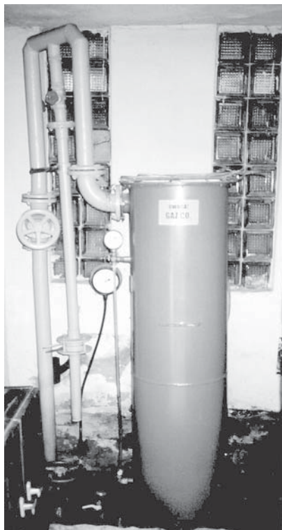
Rys. 7.7. Separator przy odwiercie B-4 w Dusznikach Zdroju, skonstruowany i wykonany dla ustalonych warunków eksploatacji (fot. Wojciech Ciężkowski).
