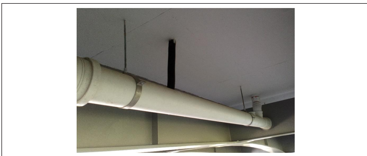
Rys. 5-8. Odprowadzenie wody z urządzeń odwadniających na obiekcie mostowym (z wpustów i sączków)
