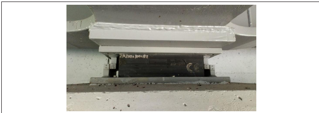
Rys. 5-2. Łożysko elastomerowe zamontowane na podporze
