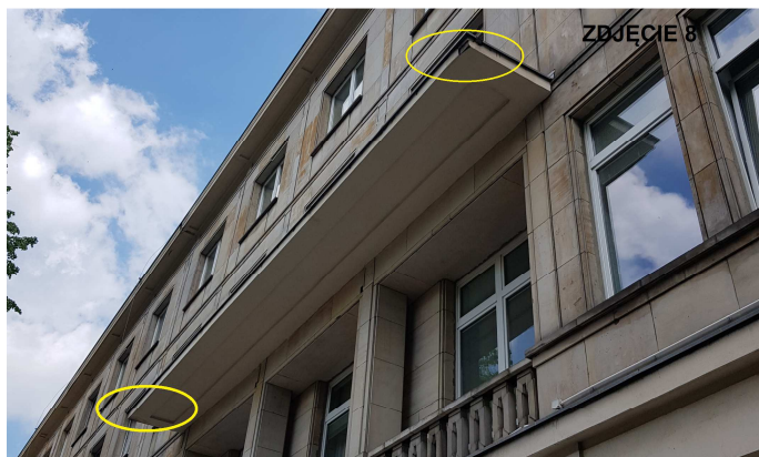
— ODSPOJENIE TYNKÓW
