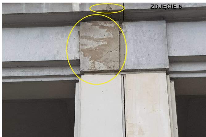
ODSPOJENIE TYNKÓW
