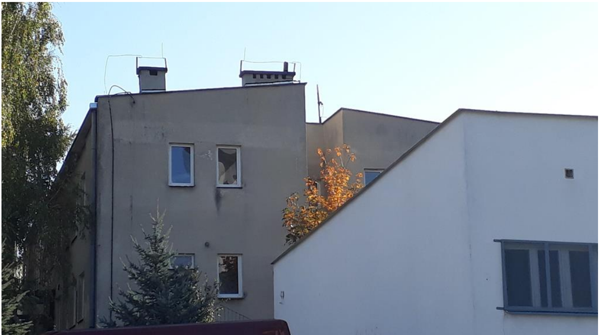
Rys. 3 Miejsce montażu SMS PEM – Przedszkole nr 45, Lublin – widok z poziomego gruntu
