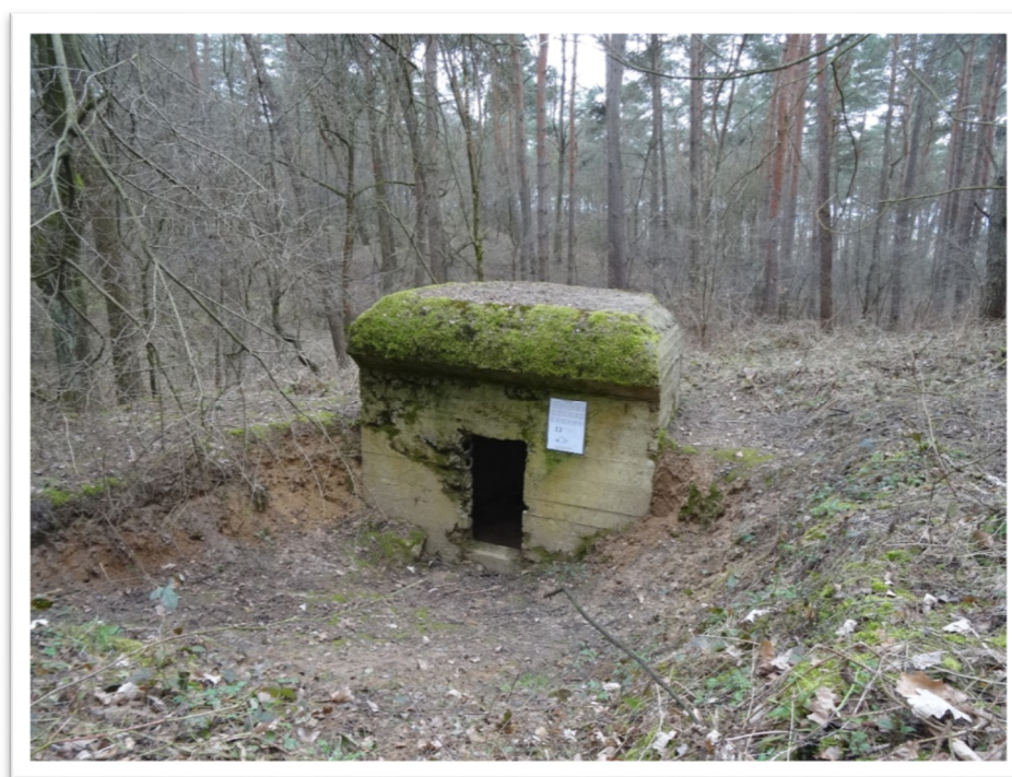
Fotografia 8 Jeden z lekkich bunkrów żelbetowych będący częścią systemu Samodzielnego Ośrodka Oporu „Dobieszewo” znajdujący się na terenie leśnictwa Smogulec (fot. K. Kołodziejczak)
