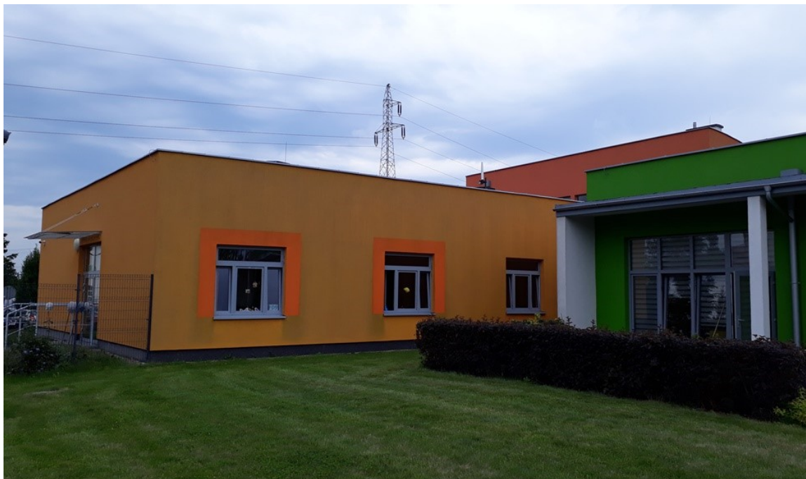
Rys. 2 Miejsce montażu SMS PEM – Szkoła Podstawowa nr 24 w Płocku
