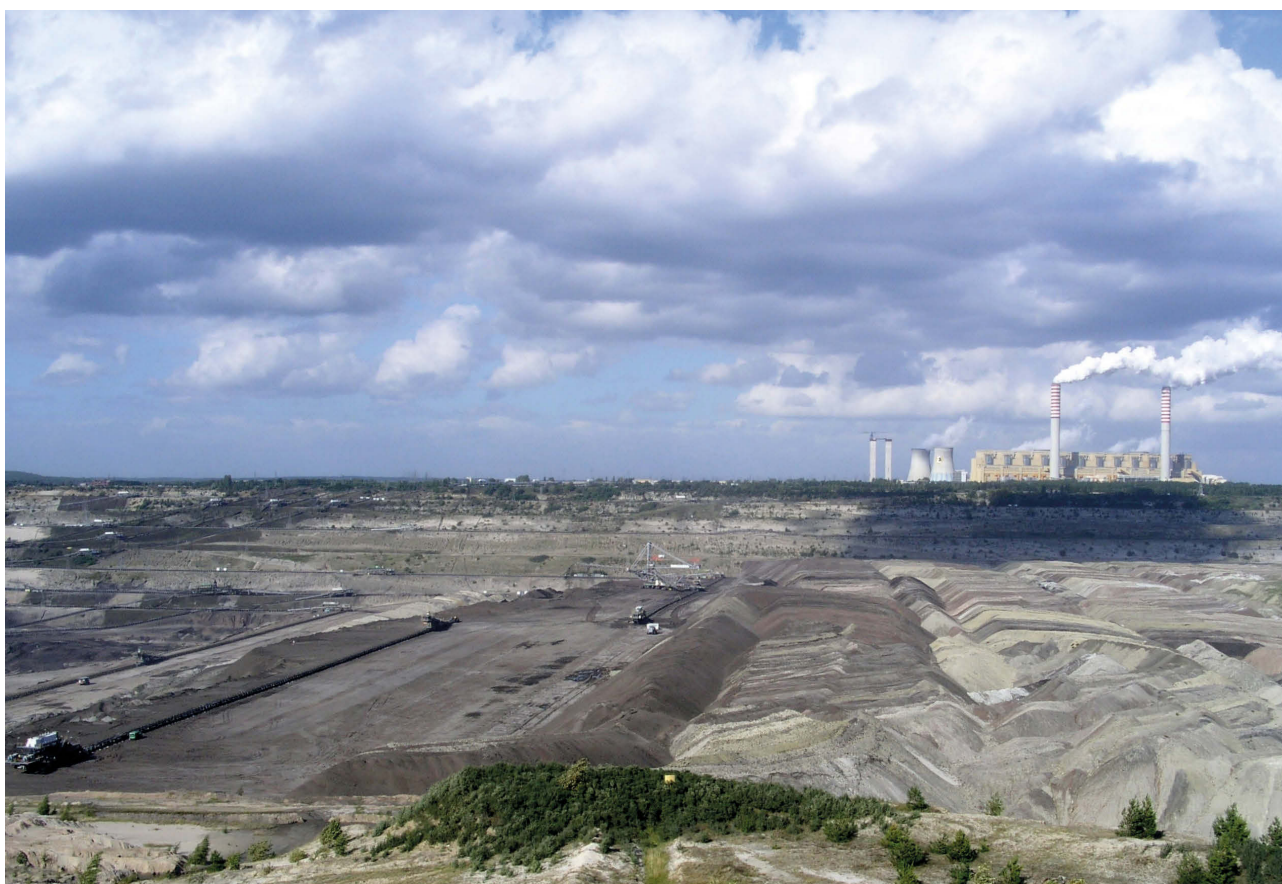
Fot. 59. Mezoregion Wysoczyzna Bełchatowska (318.81). Kopalnia Węgla Brunatnego i Elektrownia Bełchatów (fot. Elżbieta Papińska)
