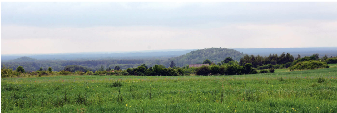
Fot. 80. Mezoregion Obniżenie Górnej Warty (341.25). Przybynow – hałdy po eksploatacji rud żelaza (fot. Jerzy Nita)
