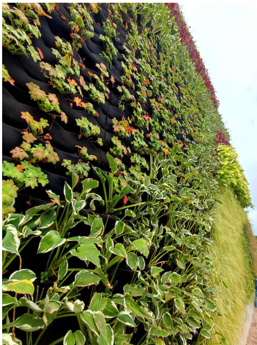
Fot. 7. Dofinansowany przez WFOŚiGW w Łodzi ogród wertykalny na ścianie budynku w Radomsku.
