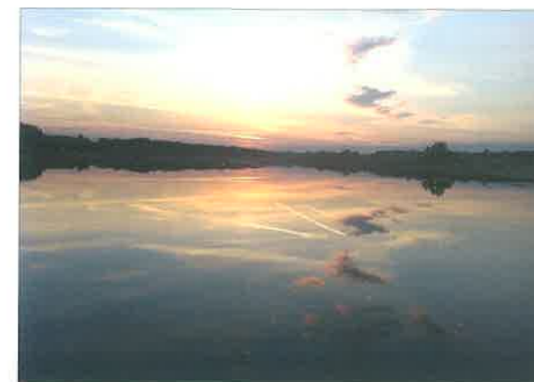
◆ Zbiornik retencyjny „Niewiadoma”, wybudowany w latach 2010–2013.
