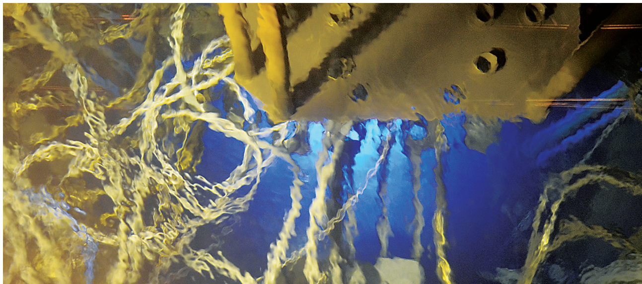
Fot. 5. Widok rdzenia reaktora MARIA podczas pracy na pełnej mocy (obraz rozmyty przez falowanie wody w basenie)
