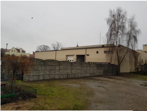
Fot. 1 Płot na terenie JRG
