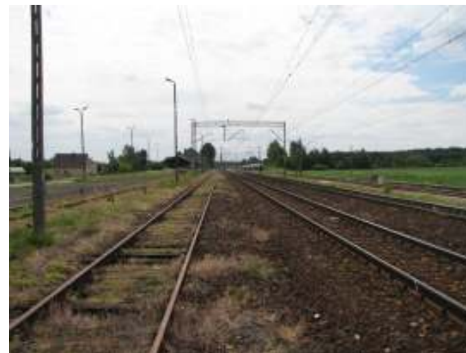
Fot. 6. Boronów, RB2, linia kolejowa nr 131 w kierunku Kalet
