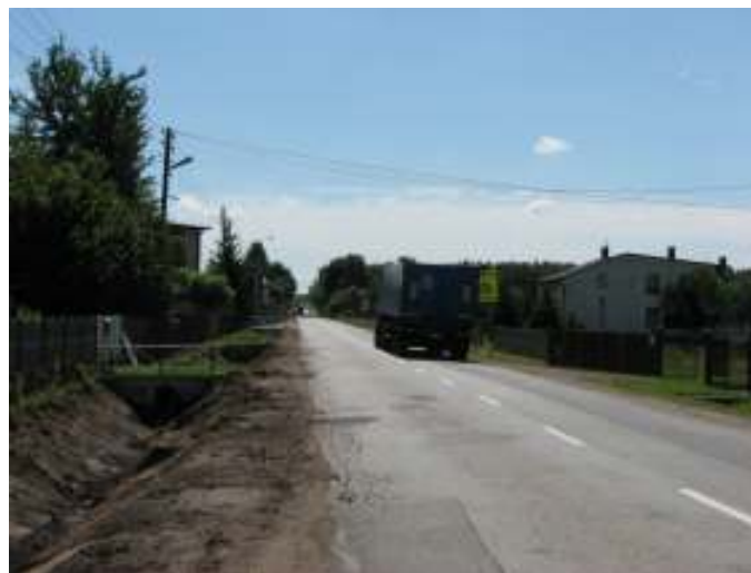
Fot. 3. RB1, Boronów, ul. Wolności (DW 905) w kierunku miejscowości Psary
