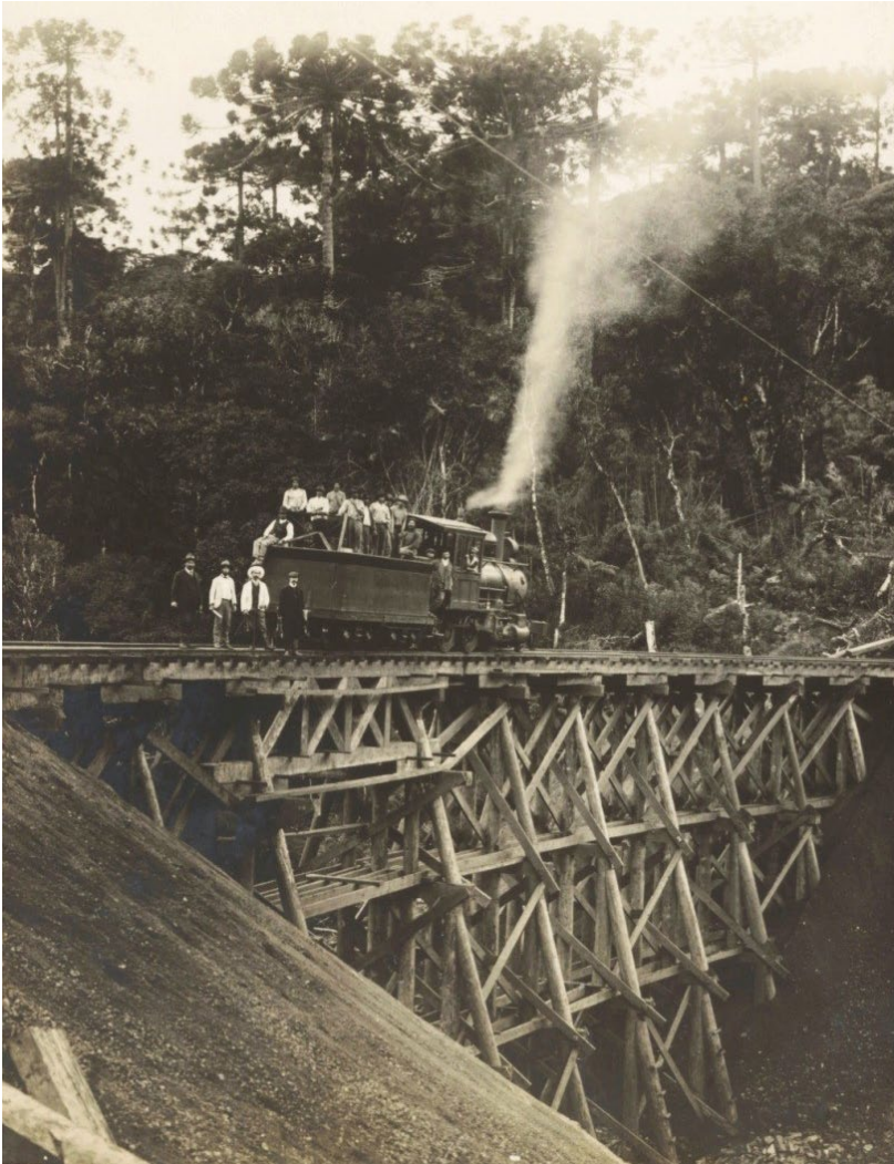
Próba wytrzymałości mostu na trasie kolei Parana – Santa Catarina (zdjęcie z archiwum T. Wierzbowskiego udostępnione dzięki uprzejmości J. Łuki).
