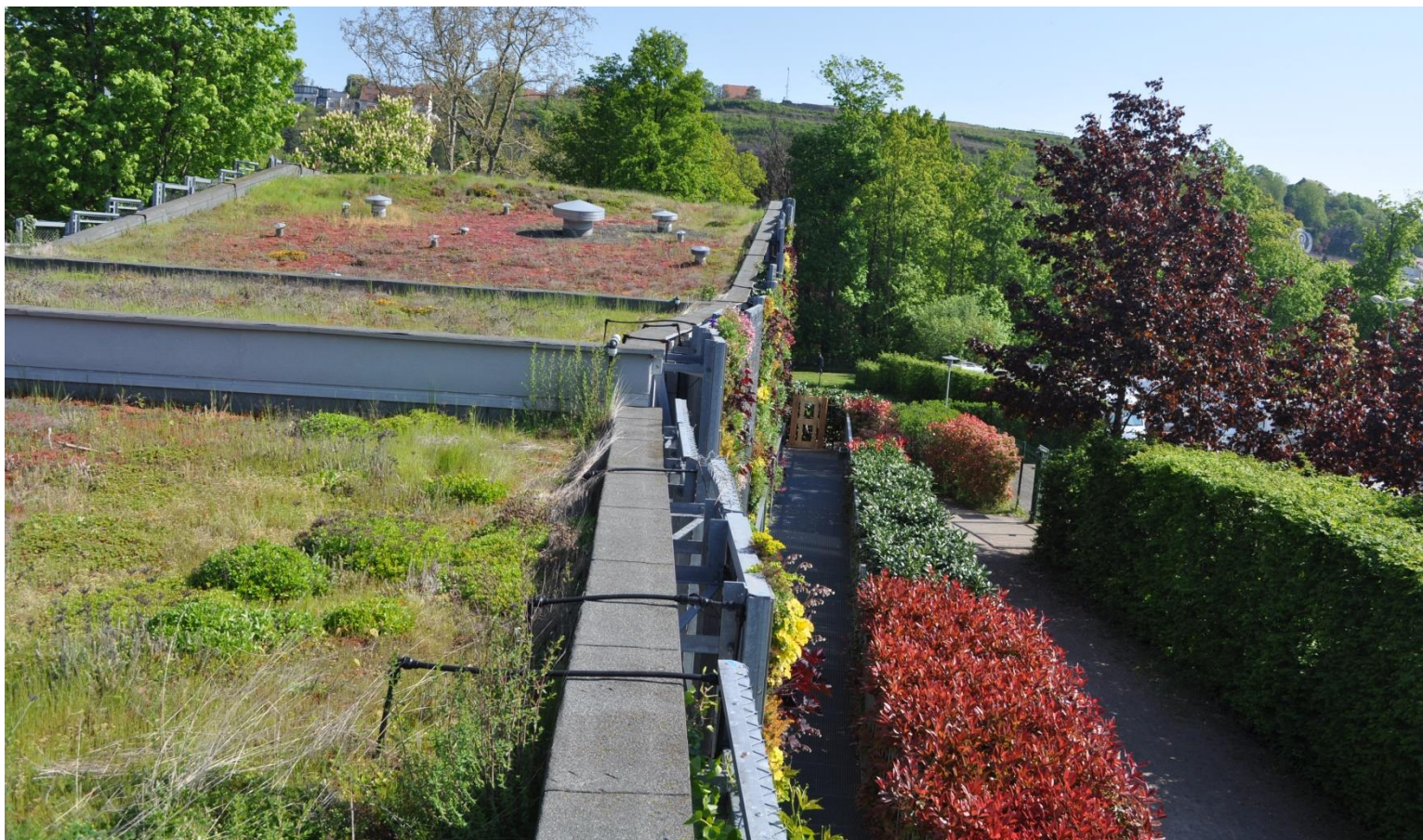
Fot. M. Weber-Siwirska
