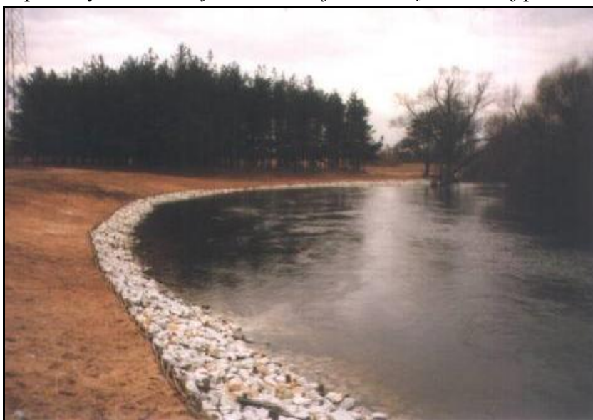
Rysunek 5.1.3. Przykład budowli regulacyjnej na rzece (opaska brzegowa), widoczne naturalne materiały użyte do budowy - faszyna, kamień, drewno
