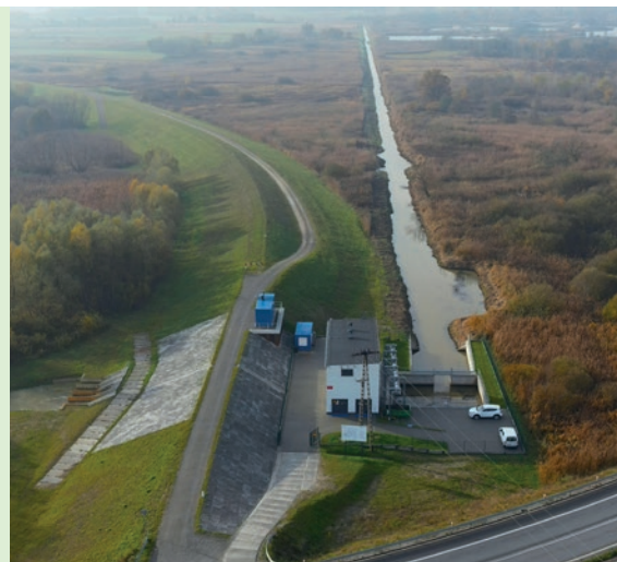
Przepompownia na Łęgu wyremontowana w ramach inwestycji
