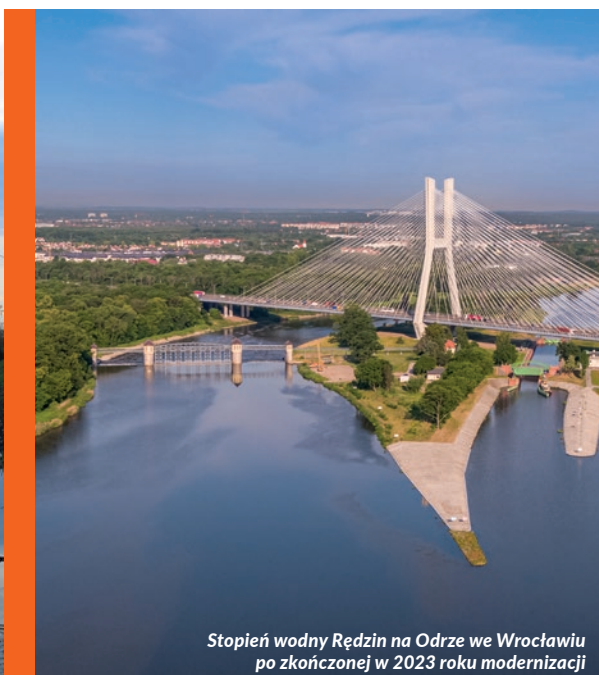
Górny awanport wyremontowanej śluzy Ratowice na Odrze we Wrocławiu
