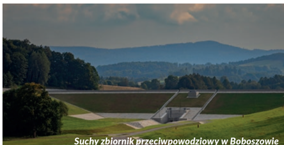
Suchy zbiornik przeciwpowodziowy w Boboszowie
