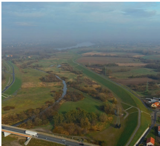
Obwałowanie Łęgu rozbudowane w ramach inwestycji
