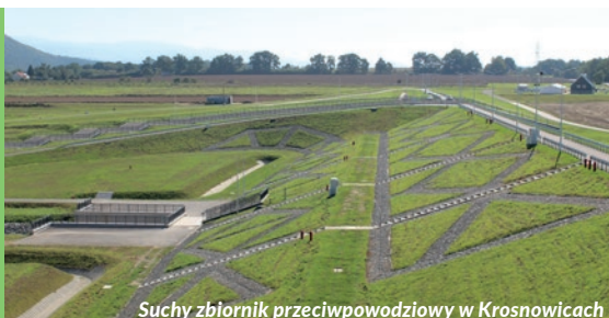
Suchy zbiornik przeciwpowodziowy w Krosnowicach
