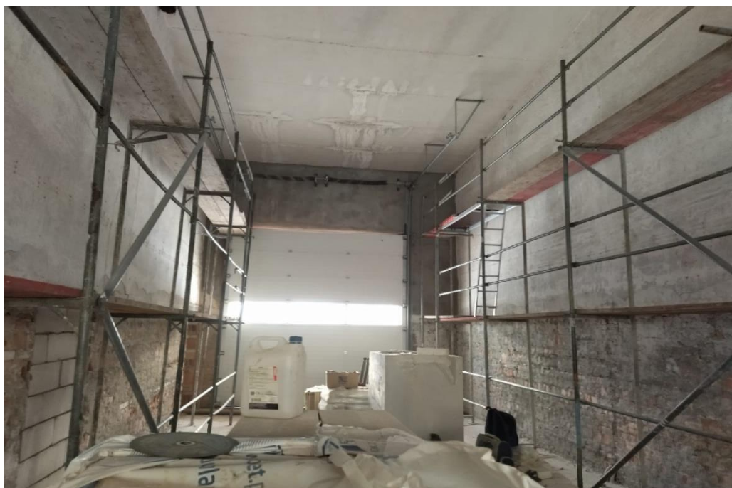
Fot. 26 Przebudowa budynku warsztatowo-magazynowego JRG Nr 2 w Miastku
