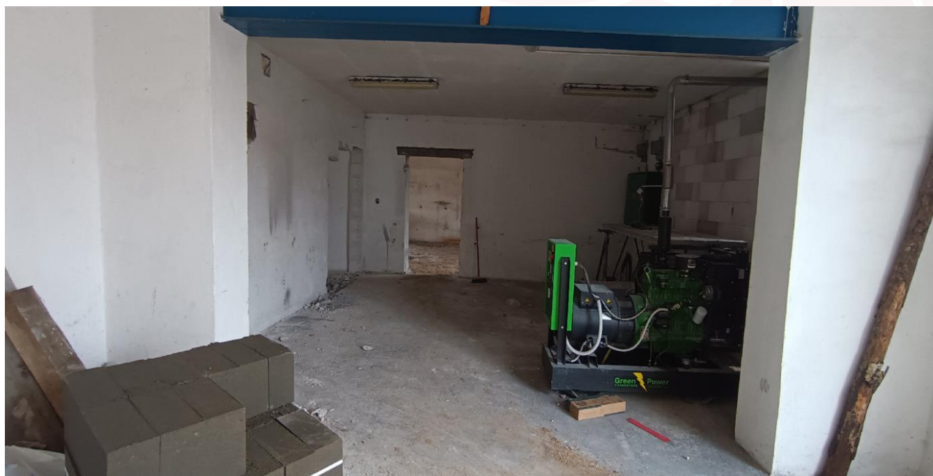
Fot. 23 Przebudowa budynku warsztatowo-magazynowego Komendy Powiatowej PSP w Bytowie
