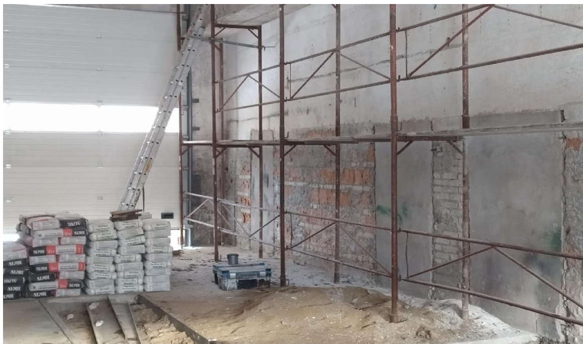
Fot. 24 Przebudowa budynku warsztatowo-magazynowego JRG Nr 2 w Miastku
