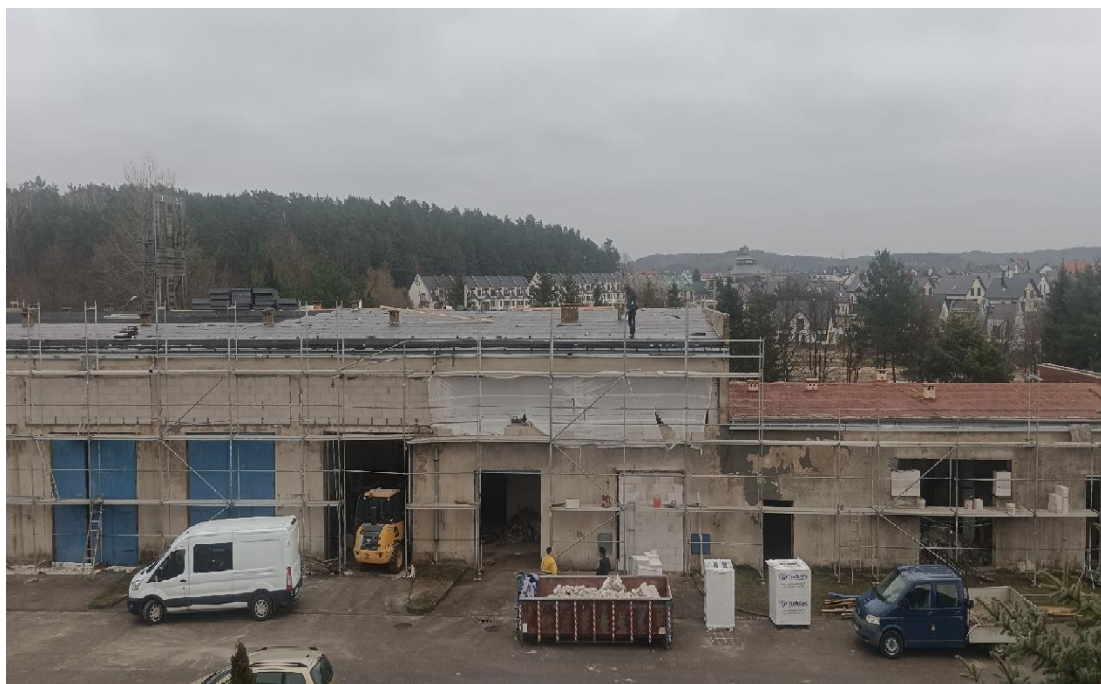
Fot. 20 Przebudowa budynku warsztatowo-magazynowego Komendy Powiatowej PSP w Bytowie
