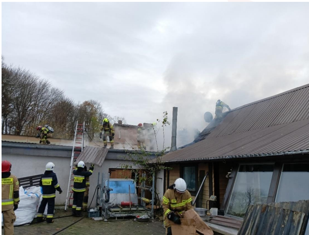
Fot. 11 16.11.2023 r. – Pożar budynku sklepu w Bytowie
