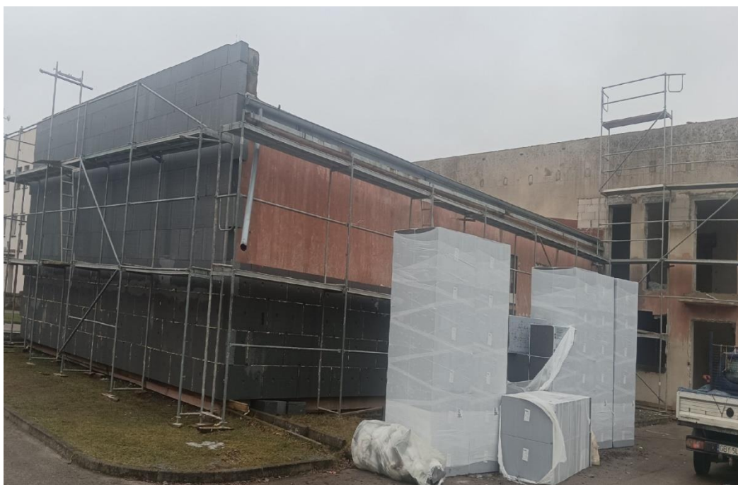
Fot. 22 Przebudowa budynku warsztatowo-magazynowego Komendy Powiatowej PSP w Bytowie
