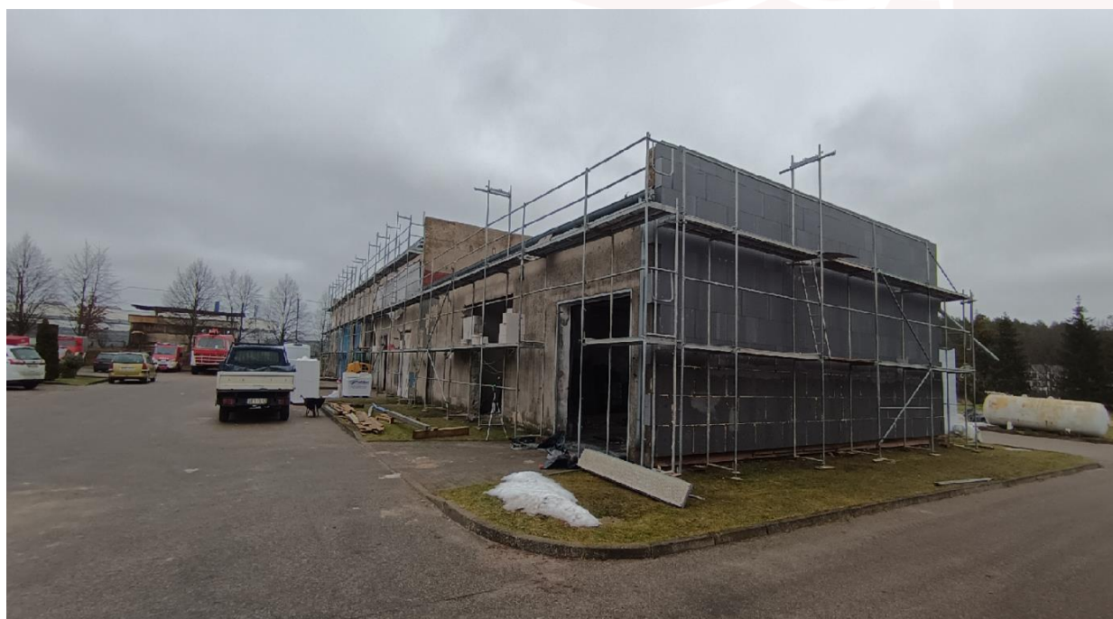
Fot. 21 Przebudowa budynku warsztatowo-magazynowego Komendy Powiatowej PSP w Bytowie
