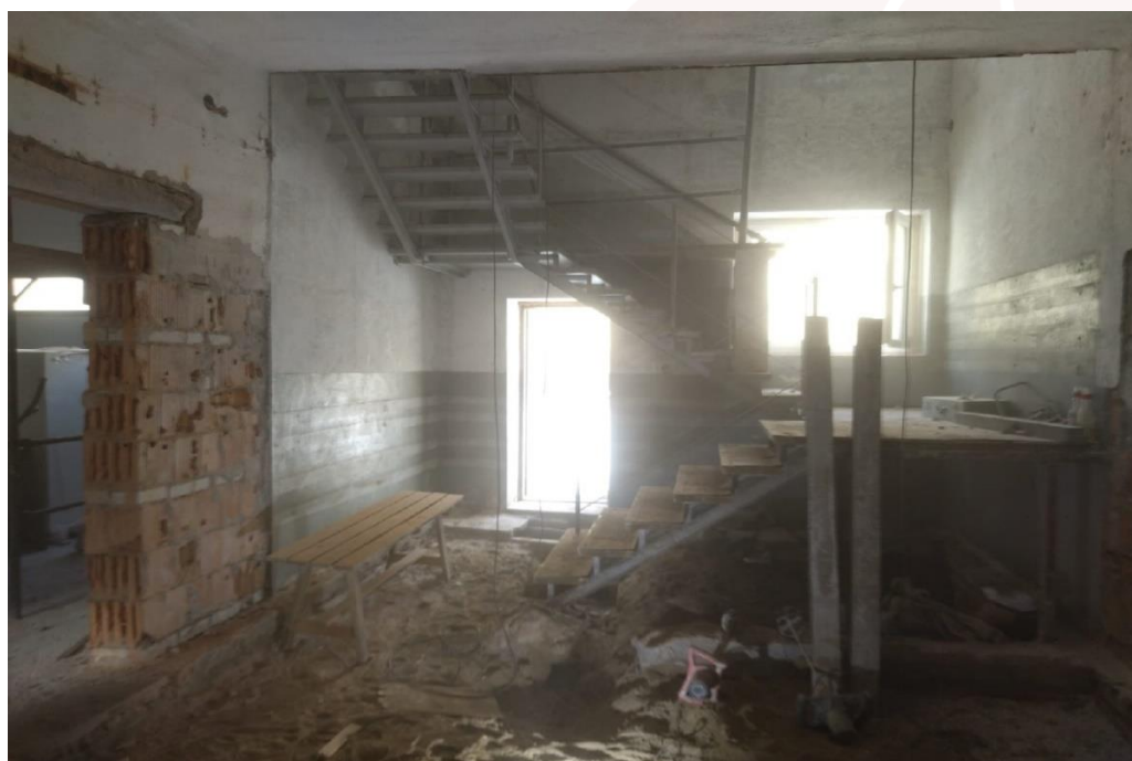
Fot. 25 Przebudowa budynku warsztatowo-magazynowego JRG Nr 2 w Miastku
