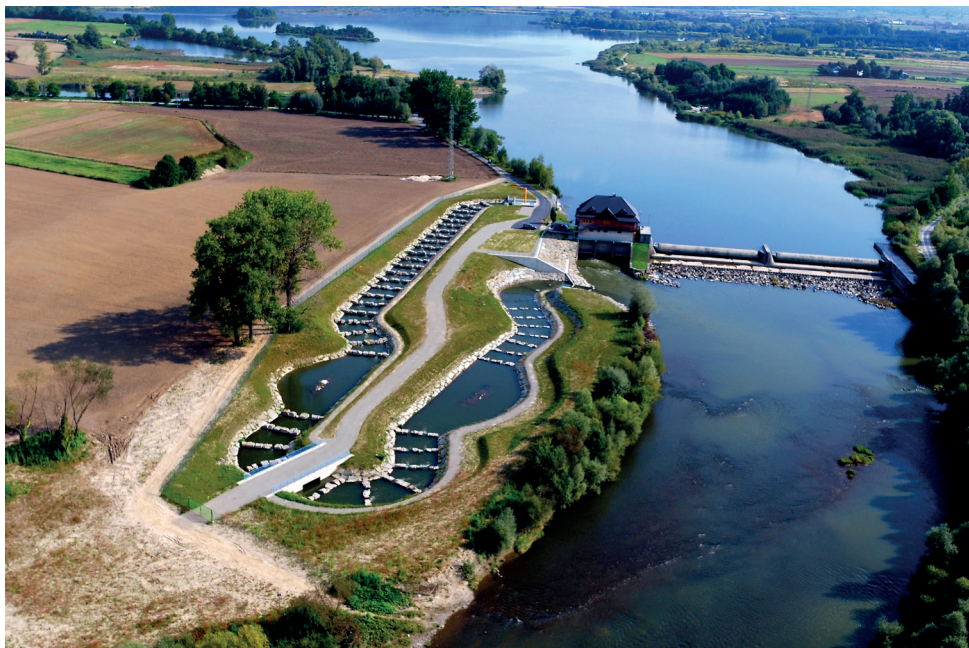
Przełupka wybudowana w ramach projektu „Likwidacja barier migracyjnych dla organizmów wodnych na rzece Wistoce i jej dopływach – Ropie oraz Jasiołce”
