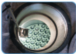
Przechowalnik wypalonego paliwa jądrowego - obiekt nr 19
