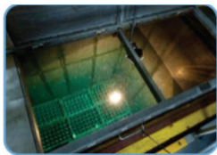
Przechowalnik wypalonego paliwa jądrowego - obiekt nr 19a
