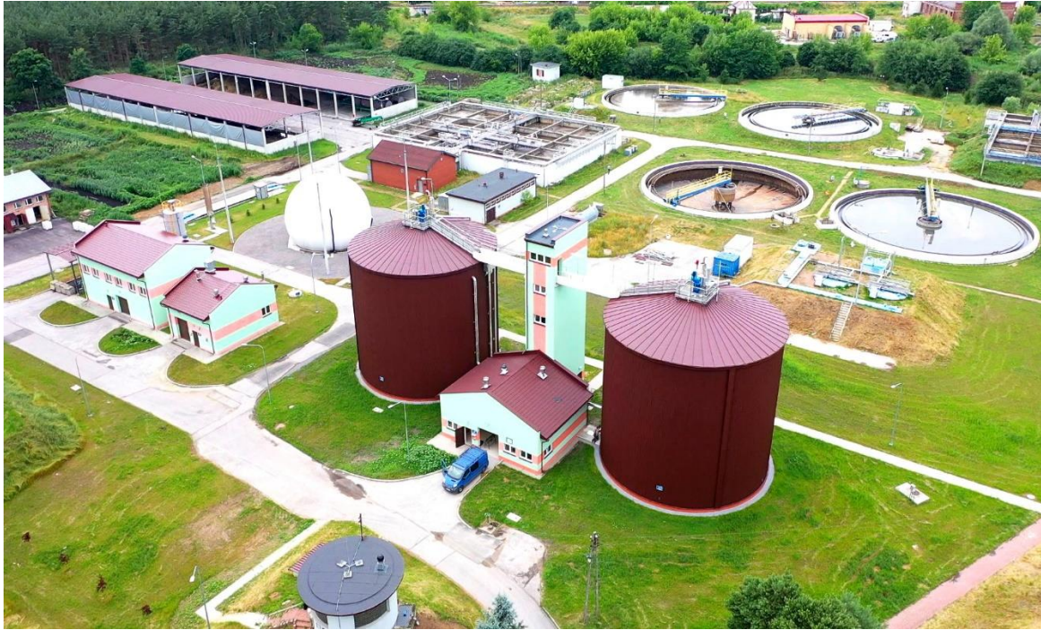
Fot. 4 Modernizacja części osadowo – biogazowej oczyszczalni ścieków przy ul. Bocznej 42 w Starachowicach.
