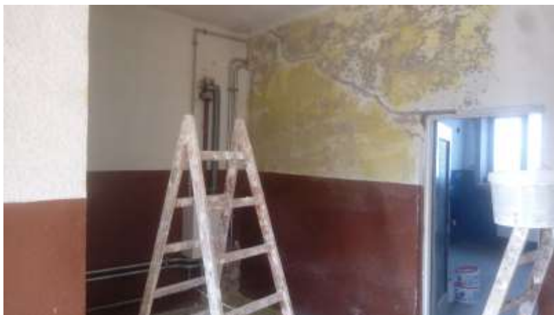
Pomieszczenia myjni w trakcie remontu
