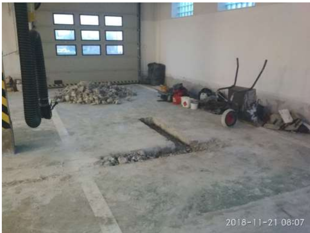
Remont posadzek w garażu głównym
