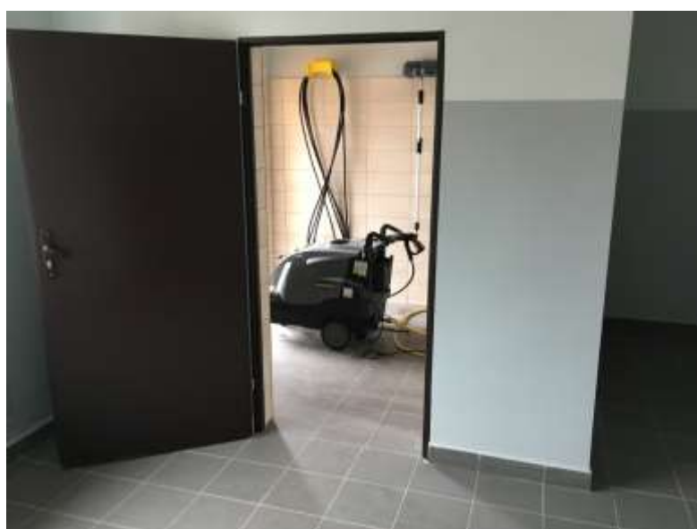
Wyremontowane pomieszczenia myjni
