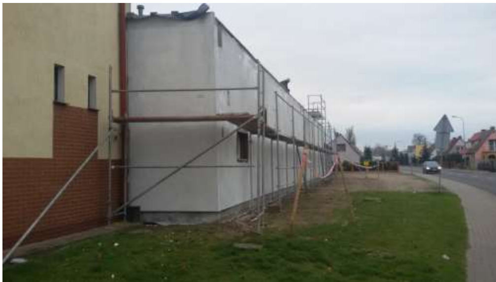
Prace budowlane na budynku przyległym do JRG Nr 2
