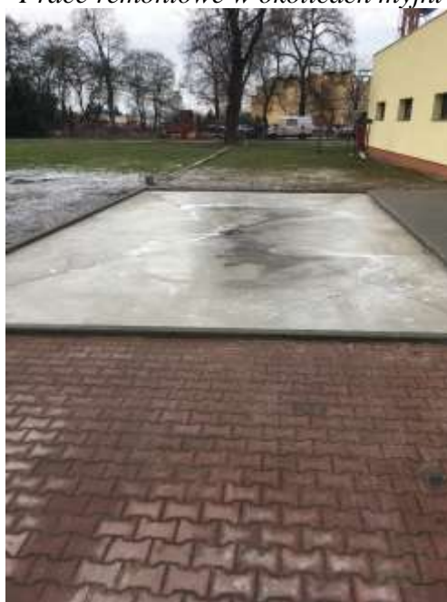
Wyremontowane stanowisko myjni
