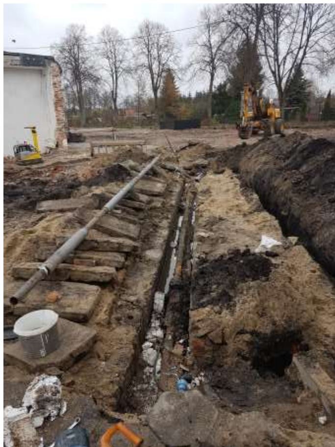
Nowe, tymczasowe ujęcie wody oraz linia ciepłownicza
