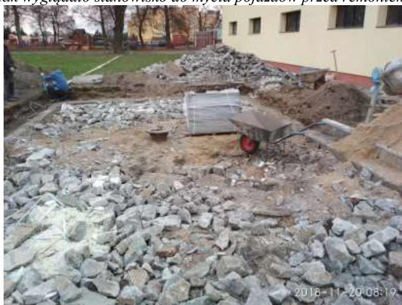
Prace remontowe w okolicach myjni
