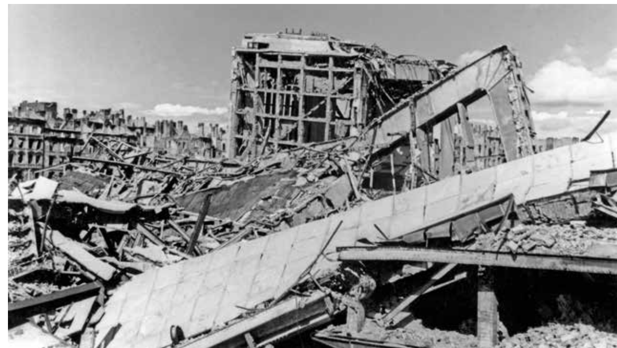
Ilustracja 8.10. Zburzony przez Niemców nowoczesny (oddany do użytku w 1939 r.) budynek Dworca Głównego w Warszawie (lipiec 1945 r.) (Zbiory IPN)
