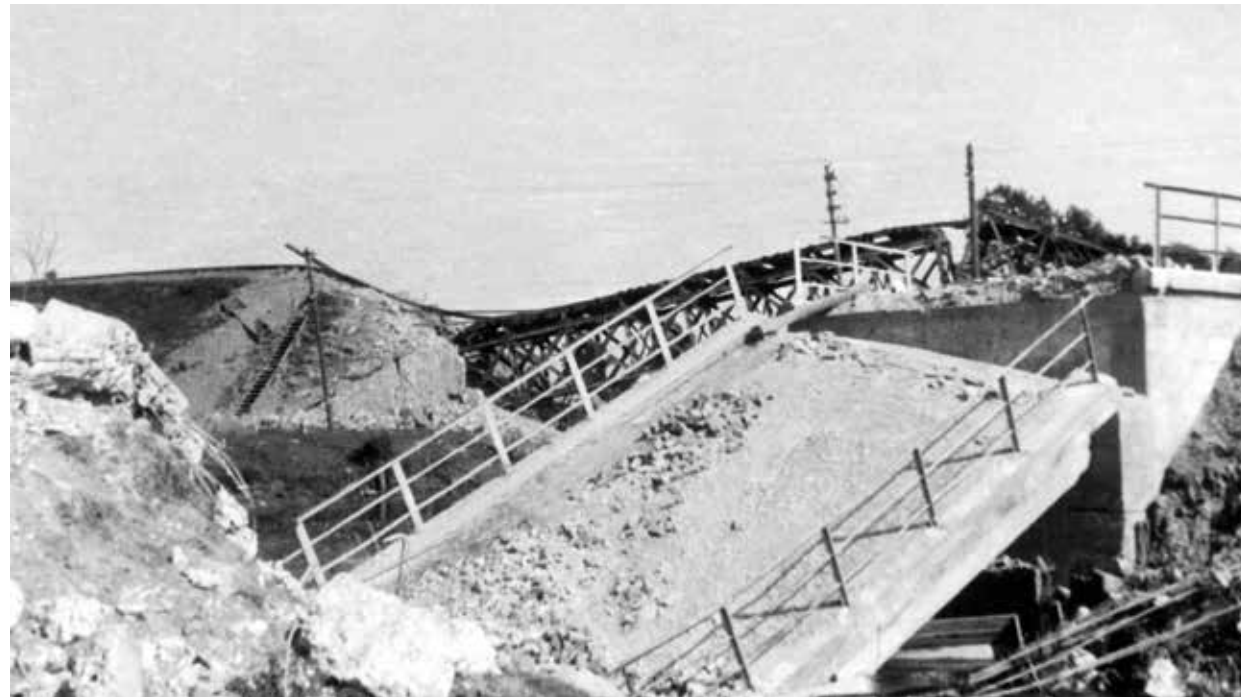
Ilustracja 8.2. Zniszczony wiadukt kolejowy w Zamościu (Zbiory IPN)
