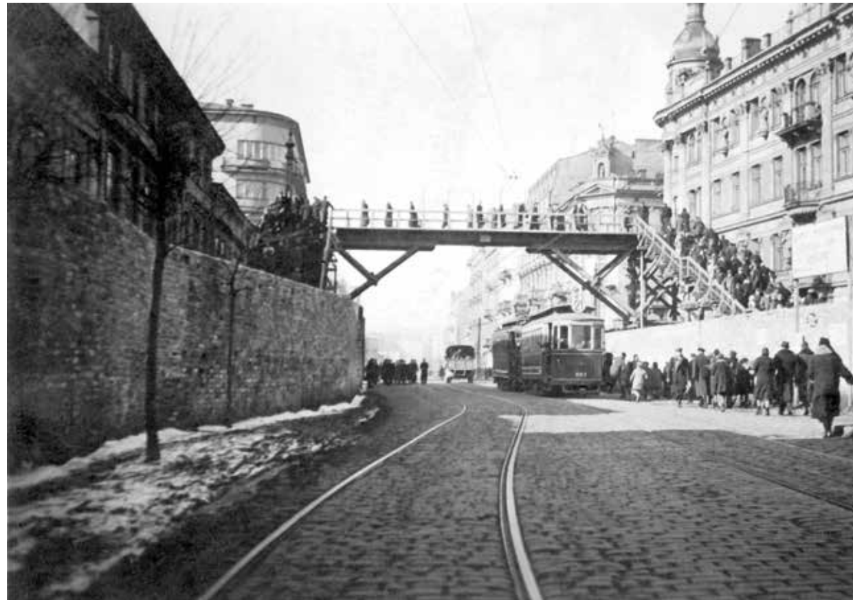
Ilustracja 4.20. Drewniana kładka łącząca dwie części getta w Warszawie (Zbiory IPN)
