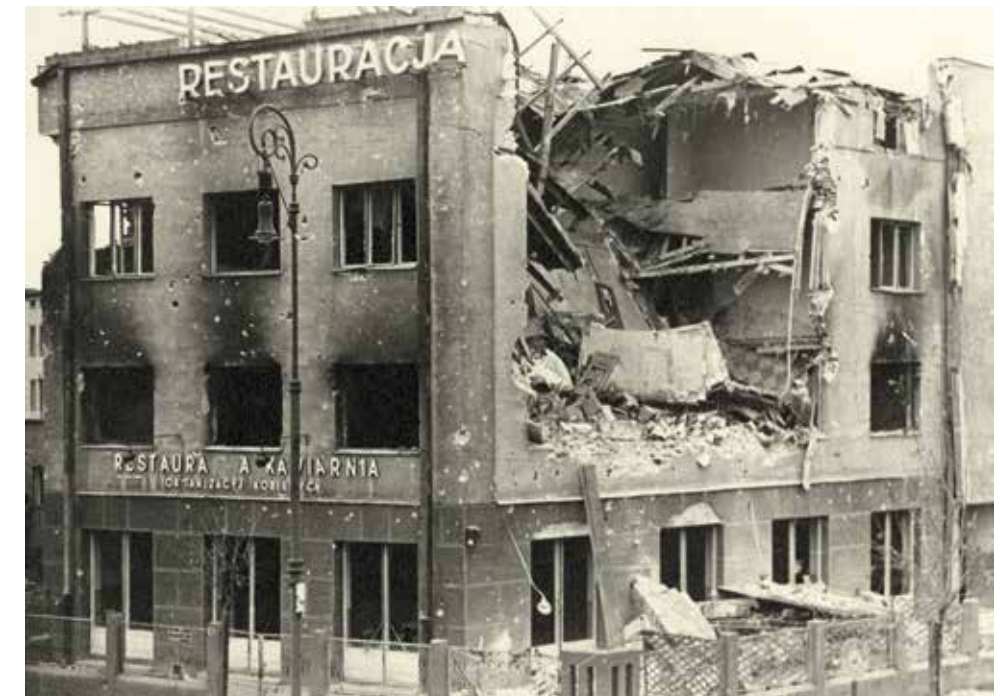
Ilustracja 1.51. Zniszczony budynek restauracji na rogu ulic Jakubowskiej i Estońskiej w Warszawie we wrześniu 1939 r. (Zbiory IPN)
