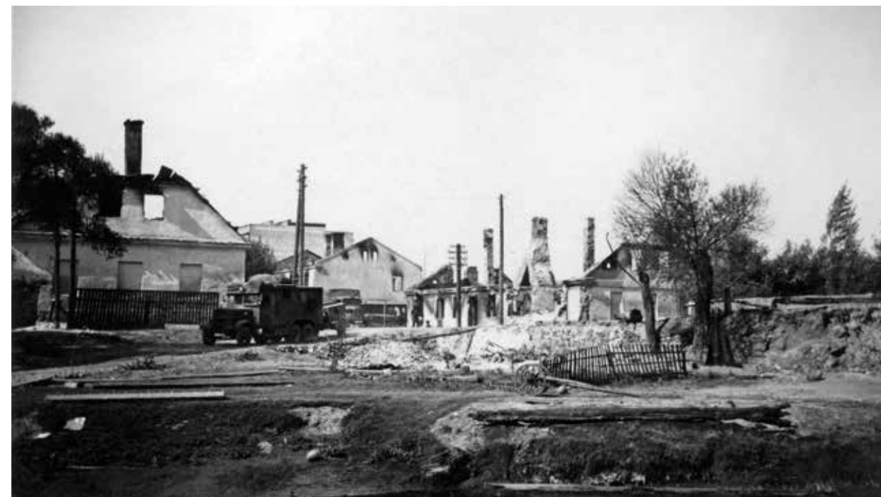
Ilustracja 1.42. Zniszczone zabudowania w okolicach Radomia (Zbiory IPN)
