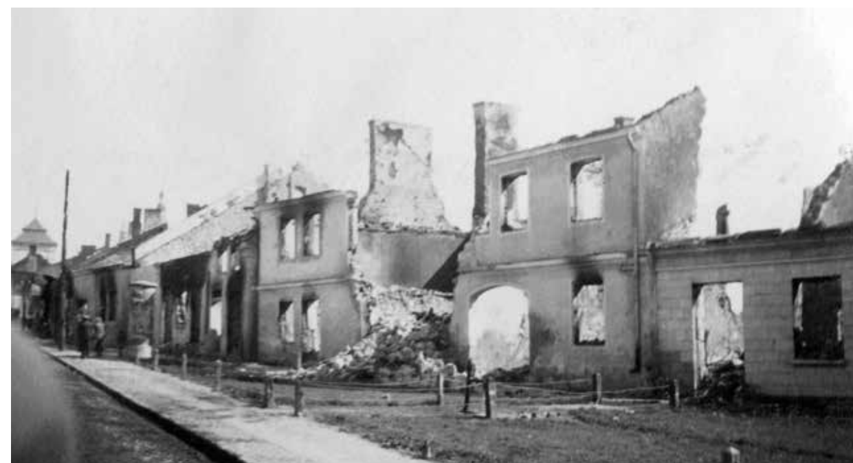
Ilustracja 1.16. Zniszczone i wypalone w trakcie walk budynki wzdłuż jednej z ulic w Pińczowie (Zbiory IPN)
