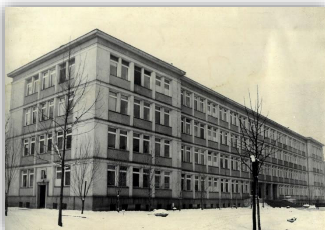
Fot. Siedziba Wojewódzkiej Stacji Sanitarно-Epidemiologicznej w Krakowie przy ul. Prądnickiej 76 (1961-obecnie) | Źródło: Archiwum własne WSSE w Krakowie
