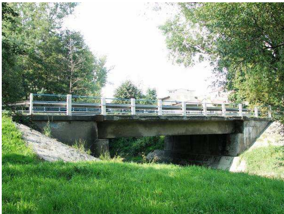
Fot. 1. Widok mostu z boku od strony góry rzeki
