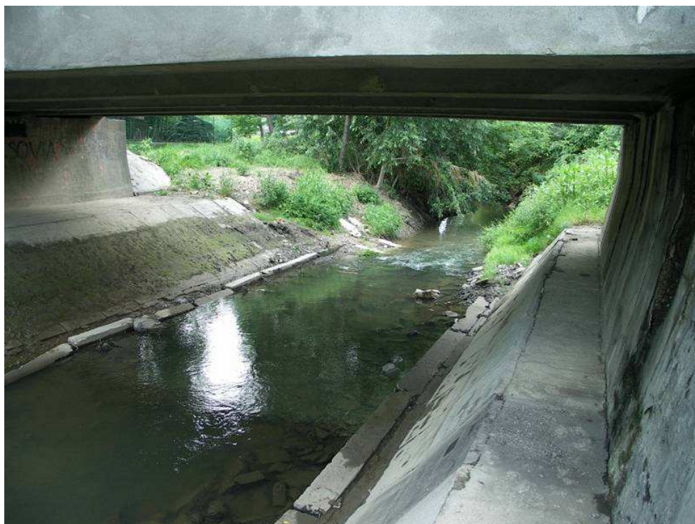
Fot. 6. Widok przeszkody i przestrzeni pod mostem
