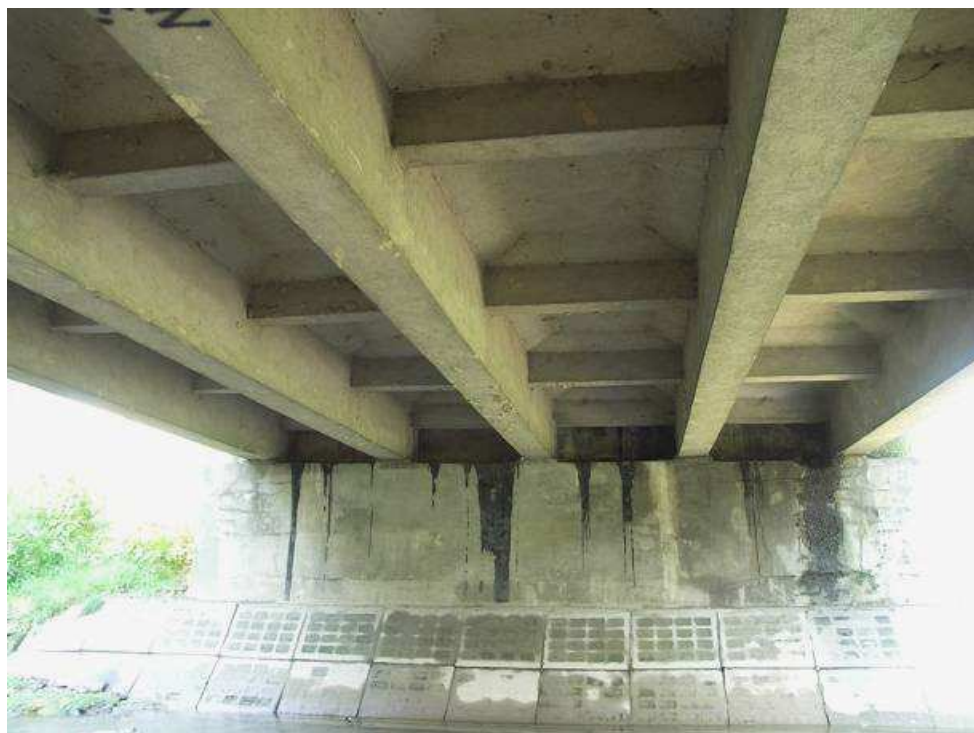
Fot. 5. Widok mostu od spodu
