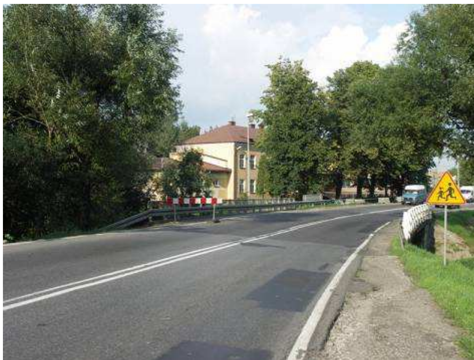
Fot. 3. Widok dojazdu od strony Rzeszowa
