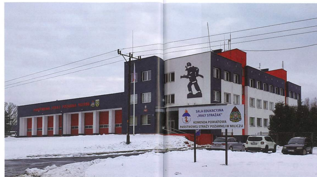
Instalacja fotowoltaiczna na budynku Komendy Powiatowej PSP w Sieradzu
