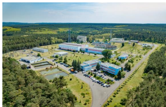
Stacja Uzdatniania Wody w Zawadzkie- https://www.zwik.zgora.pl/wp-content/uploads/2018/10/2320maja-1445.jpg
