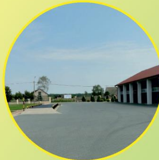
Wydzielone, utwardzone ciągi komunikacyjne i duże place manewrowe.
