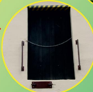
Zabezpieczenie otworów ściennych i zamontowanie zabezpieczeń drabina.
