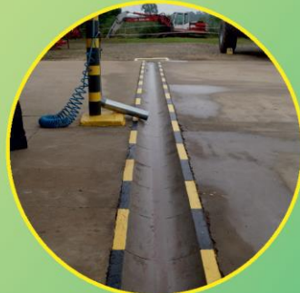
Odprowadzenie i zagospodarowanie wód opadowych.
