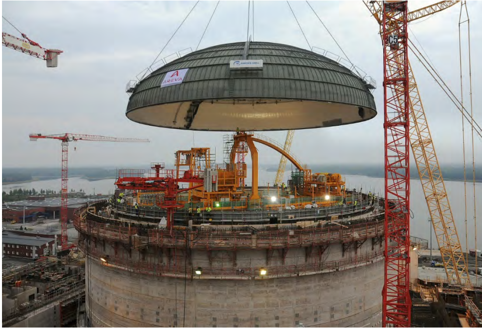
Rys. 5. Kopuła płaszcza metalowego obudowy reaktora EPR w elektrowni jądrowej Olkiluoto 3. Zdjęcie: Areva/TVO [11]
