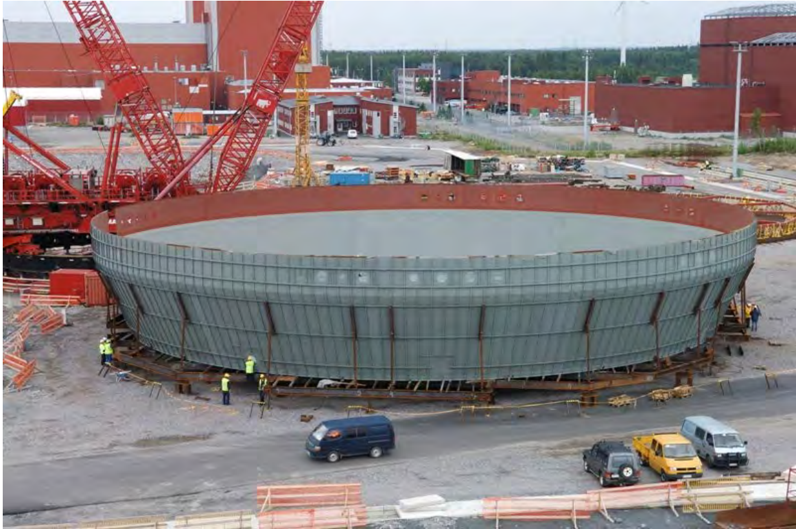
Rys. 3. Część dolna płaszcz metalowego obudowy reaktora EPR w elektrowni jądrowej Olkiluoto 3 [9]
