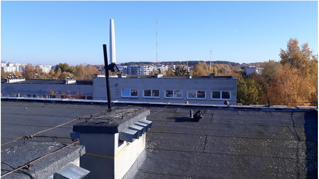
Rys. 2 Miejsce montażu SMS PEM – dach Szkoły Podstawowej nr 30, Olsztyn – widok na odległy maszt RTCN Olsztyn Pieczewo
