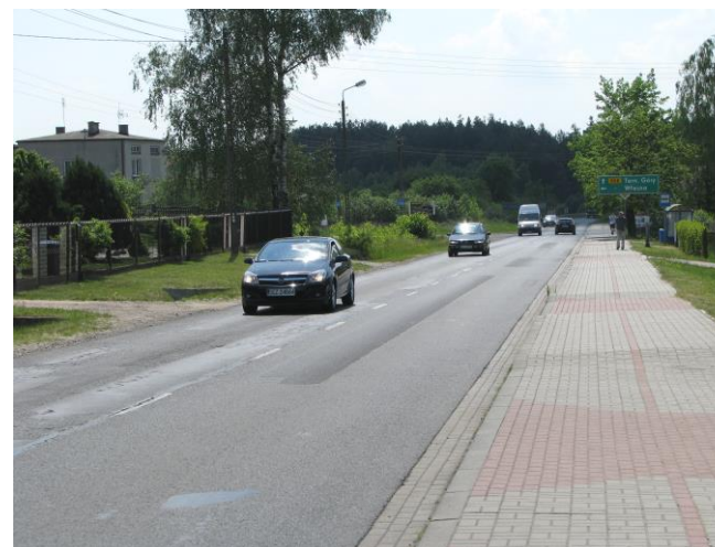
Fot. 3. Starcza, RB1. Badany odcinek ul. Gliwickiej (DW 908) w kierunku Tarnowskich Gór
