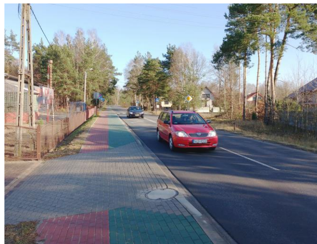
Fot. 12. Rudnik Mały, RB4. Badany odcinek ul. Śląskiej w kierunku skrzyżowania z DK 1
