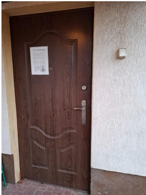
Fot. 1 Budynek mieszkalny – istniejące drzwi zewnętrzne do kancelarii
