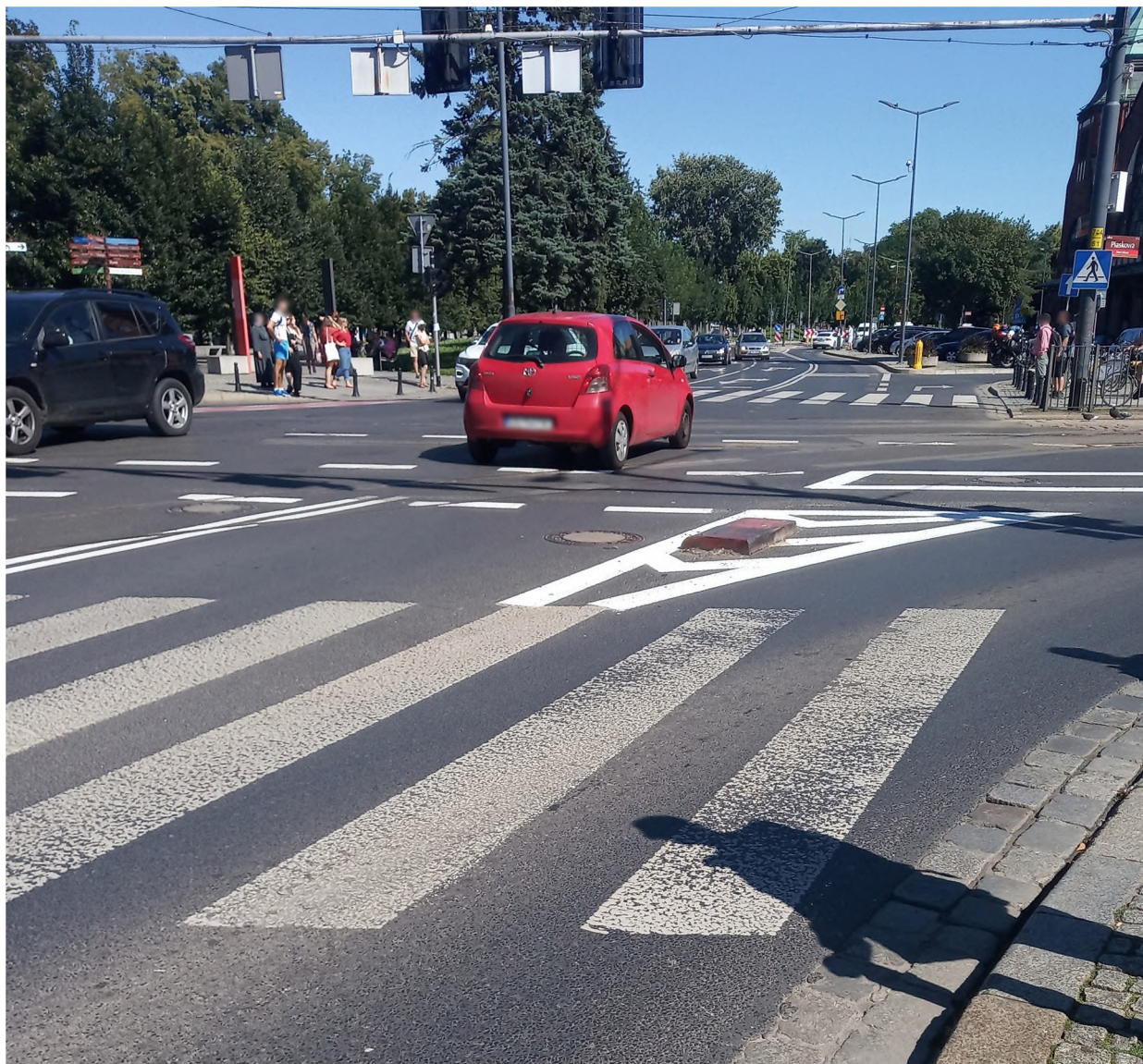
Zdjęcie 1: Przykładowa wysepka z prefabrykatów uznana przez organ zarządzający ruchem za wysepkę w krawężnikach która wydziela pas do skrętu w prawo
