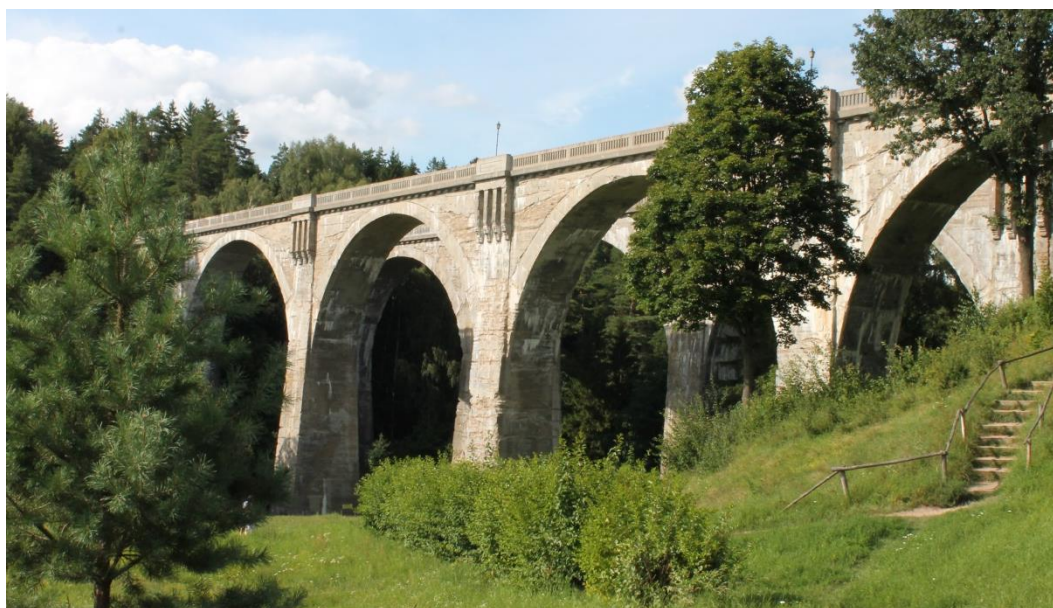
Ryc. 27 Zabytkowe wiadukty kolejowe w Stańczykach
