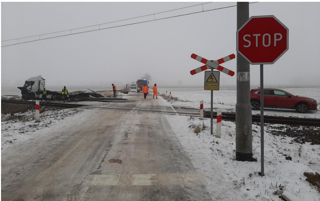
Zdjęcie 5 – Widok na przejazd z kierunku jazdy pojazdu drogowego (źródło PKBWK)
