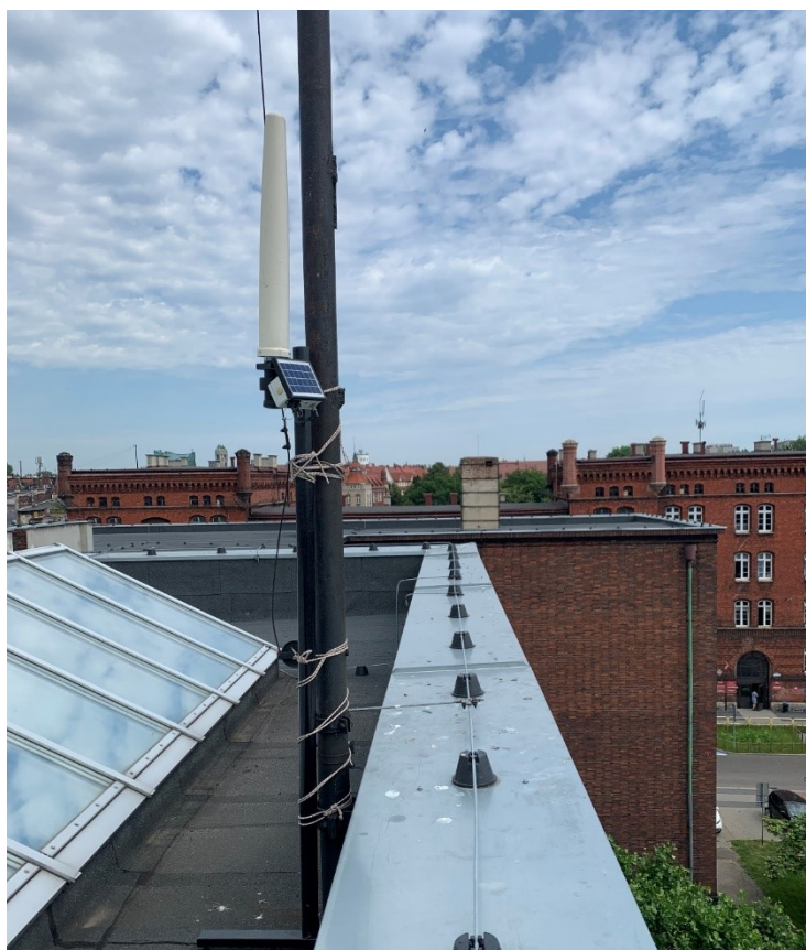
Rys. 2 Miejsce montażu SMS PEM – Zespół Szkół Mechaniczno-Elektronicznych w Bytomiu – widok na SBTK
