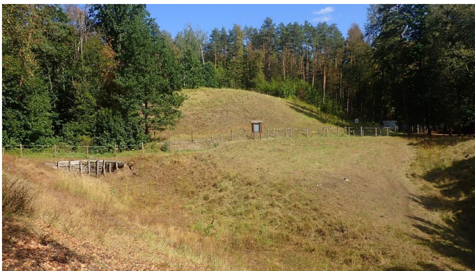
Fot. 2 Widok na rezerwat od strony południowej. Widoczna na zdjęciu tablica zlokalizowana jest przy drodze przecinającej rezerwat.
