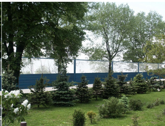
Fot.6. Wariant II - widok na drogę - ekran przezroczysty w górnej części
