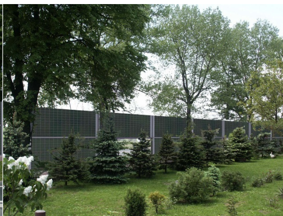
Fot.10. Wariant IV - widok na drogę - ekran typu zielona ściana z elementami przezroczystymi
