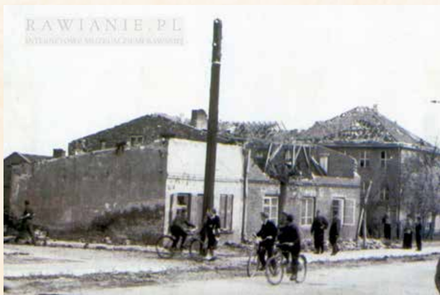
Fot. ze strony www.rawianie.pl , na zdjęciu pokazane są budynki mieszczące się obecnie naprzeciwko budynku Policji. W tle widać zniszczony dach obecnego Liceum Ogólnokształcącego im. Marii Curie Skłodowskiej, autor zdjęcia: Tomasz Gołka
