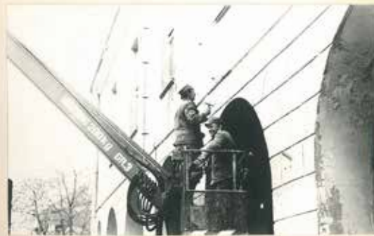
Ogn. Kacprzak Jan wraz z plut. Michałowickim Janem w trakcie malowania tynku frontowej.
