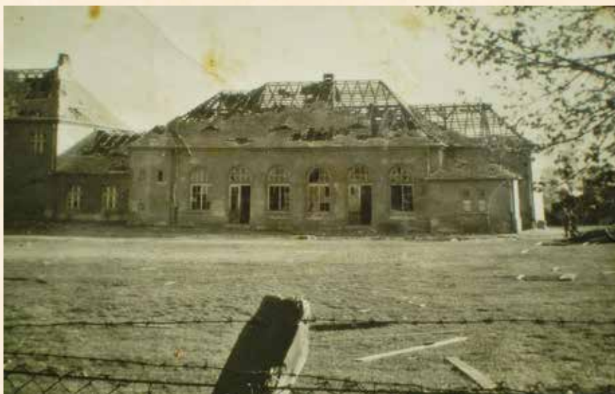
Fot. ze strony www.rawianie.pl , zniszczony budynek sali gimnastycznej Szkoły Podstawowej nr 1.
