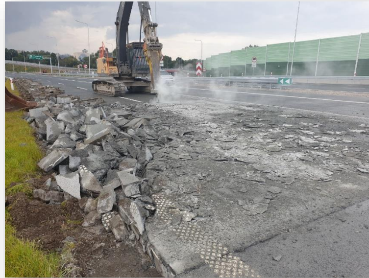
Usunięcie warstwy i ułożenie nowej
