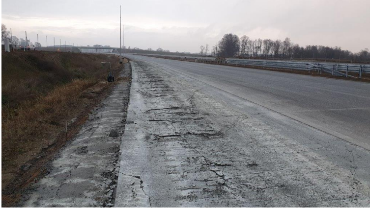
Efekty wykonywania nawierzchni betonowej w czasie deszczu
