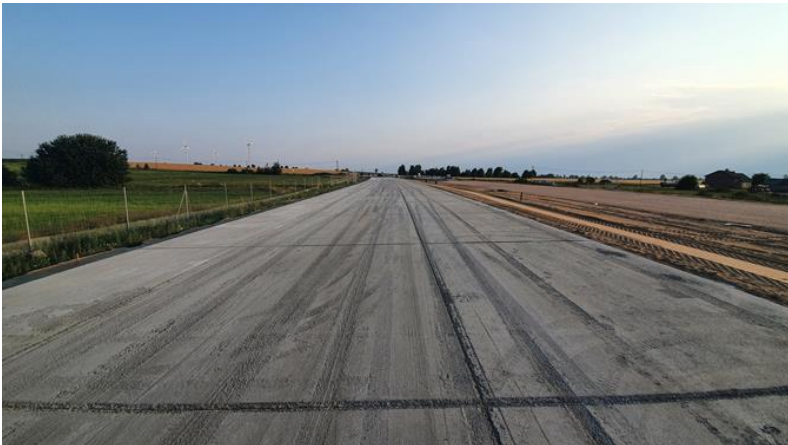
Efekty wykonywania nawierzchni betonowej w czasie deszczu
