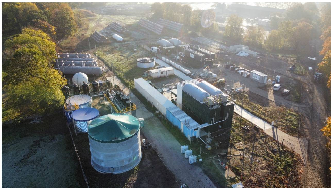
Fotografia 1. Instalacje Ułamkowo-Techniczne wybudowane przez trzy konsorcja biorące udział w przedsięwzięciu „Innowacyjna biogazownia” - instalacje zlokalizowane na terenie Rolniczego Gospodarstwa Doświadczalnego w Brodach należącym do Uniwersytetu Przyrodniczego w Poznaniu – partnera strategicznego przedsięwzięcia.
