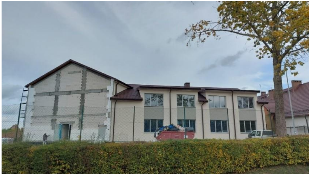
Budowa hali sportowej w Wilanowie.
