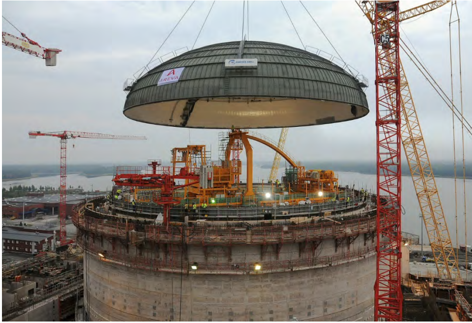
Rys. 5. Kopuła płaszcz metalowego obudowy reaktora EPR w elektrowni jądrowej Olkiluoto 3. Zdjęcie: Areva/TVO [11]
