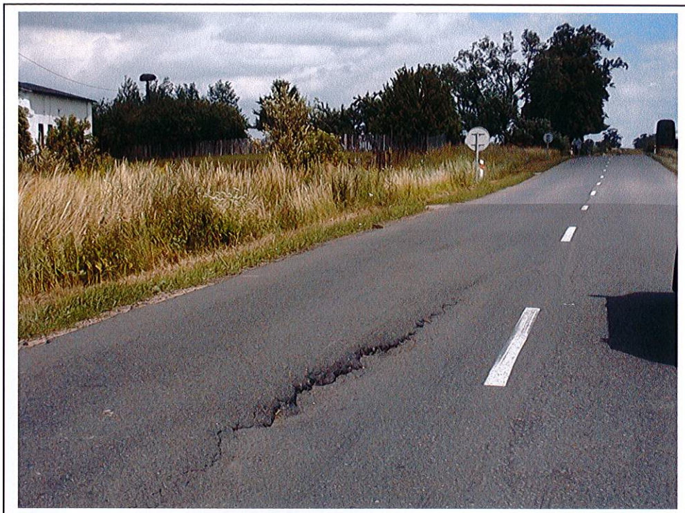
Fot. 1, 2 Pęknięcie nawierzchni (widok w kierunku Kisielic)
