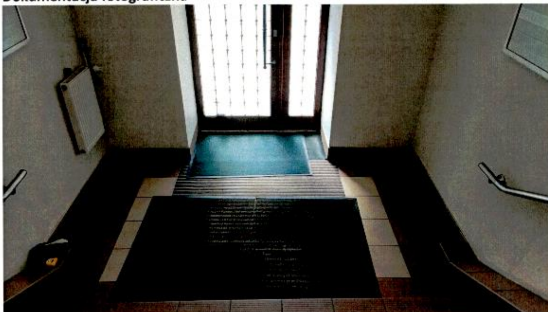
Przedsiónek do remontu
