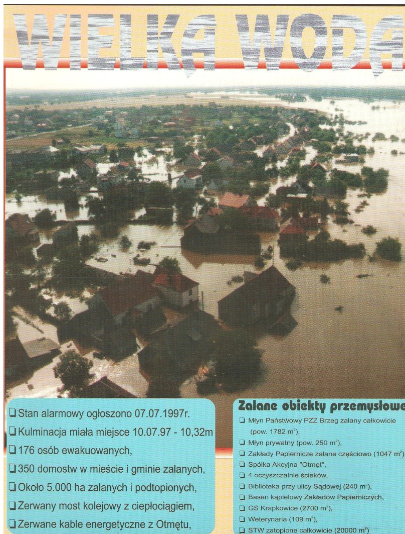
Widok na zalaną dzielnicę domków jednorodzinnych w Krapkowicach - Otmęt
