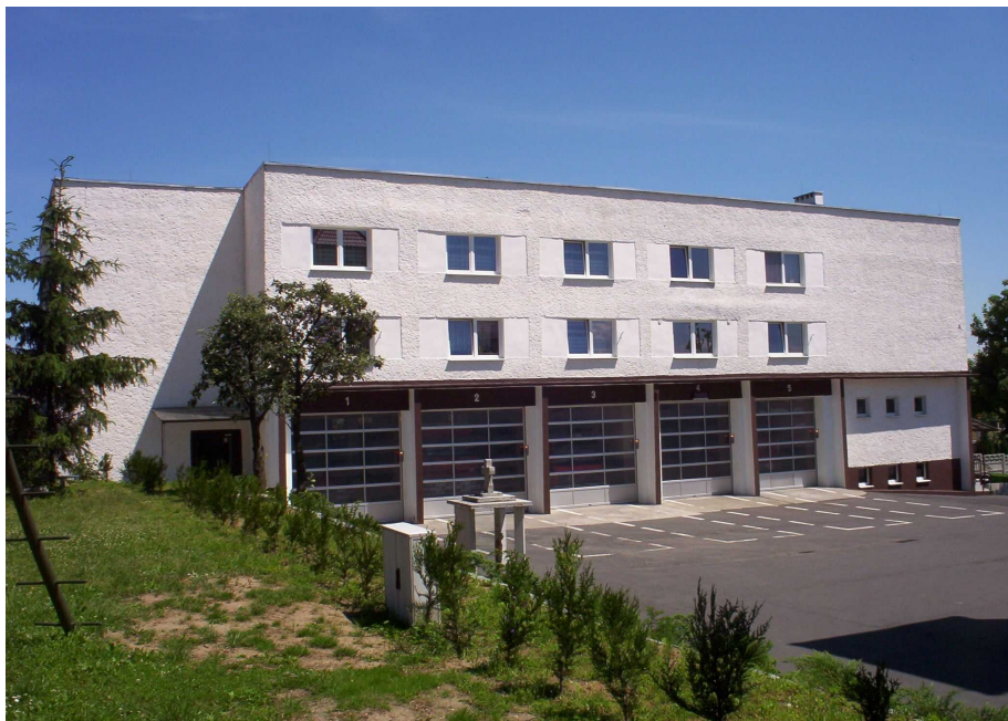
Budynek Jednostki Ratowniczo-Gaśniczej Państwowej Straży Pożarnej w Krapkowicach
