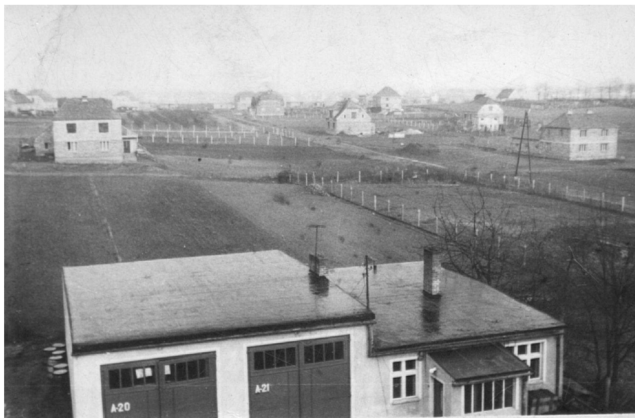
Nowy budynek Pogotowia Kierowców przy Komendzie Powiatowej Straży Pożarnej w Krapkowicach
