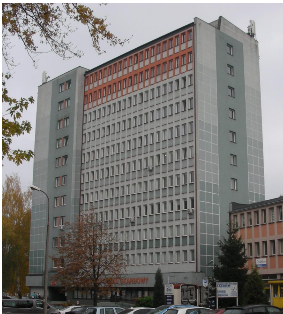
Fot. 1: Widok anten stacji bazowej ID: BIA1103_A, zlokalizowanej pod adresem: ul. Świetojańska 13, 15-082 Białystok.
