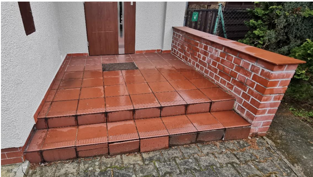
Fot. 10. Widok na wejście schodowe do budynku.
