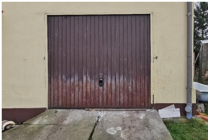
Fot. 23. Widok bramy przeznaczonej do wymiany.
