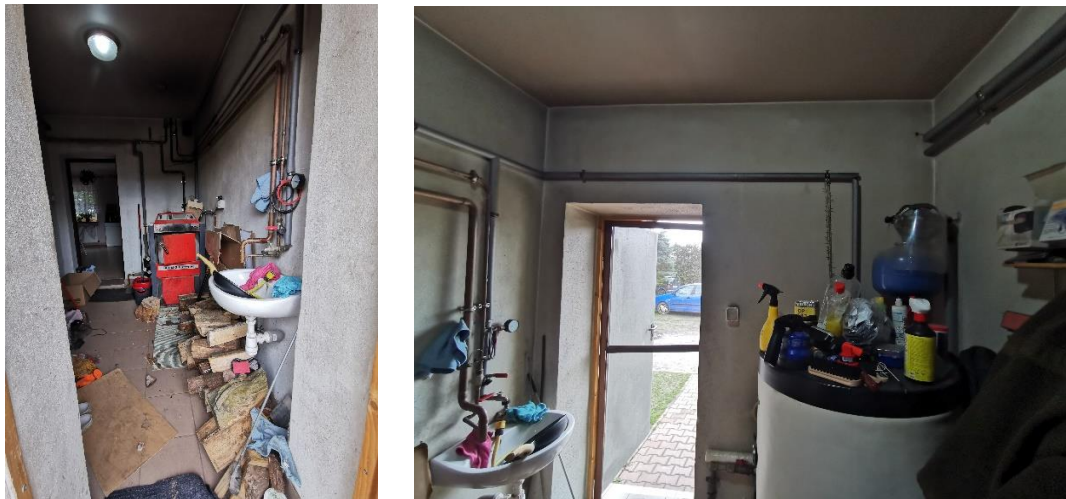
Fot. 20, 21. Widok pomieszczenia kotłowni przeznaczanego do remontu.
