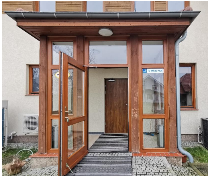
Fot. 4. Boczne wejście do budynku. Drewniane słupy oraz podbitka dachowa przeznaczone do malowania.
