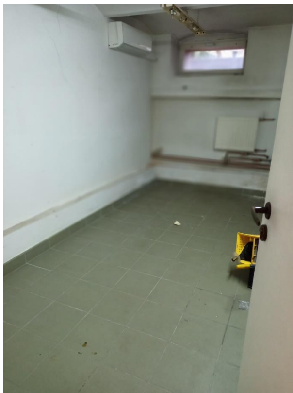
Widok na przykładowe pomieszczenie techniczno-magazynowe
