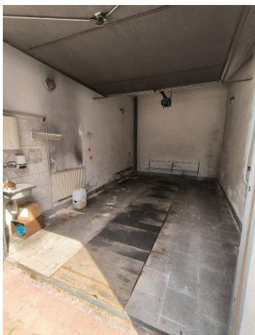
Garaże na dolnym parkingu schody na górny taras z miejscami postojowymi
